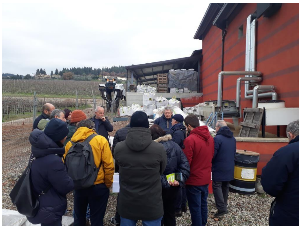
Foto 2- Impianto di scarico del cogeneratore dell'Az. Agr. Frescobaldi
